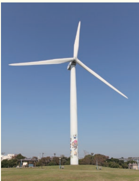
◀タワーの高さが60m、ブレード(羽)の長さが40m、合わせて100mの高さになります。
